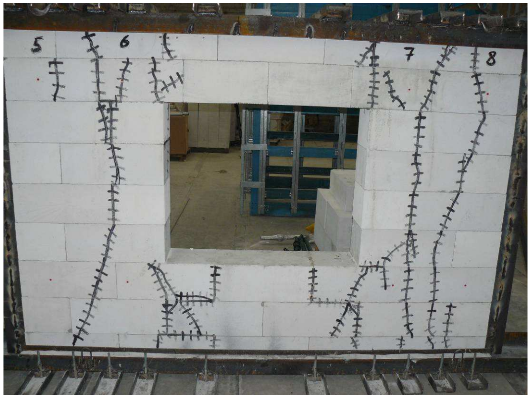
Рис.4.14. Характер образования трещин в процессе динамического нагружения
